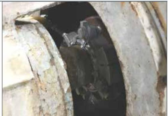
*Eine geteilte Cartridge-Dichtung 442C mit 114 mm (4,50") wurde in weniger als zwei Stunden eingebaut.*
